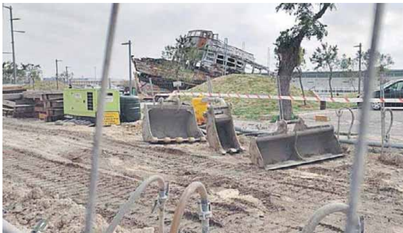
Varias bombas extraen el agua del río para poder acometer los trabajos.
