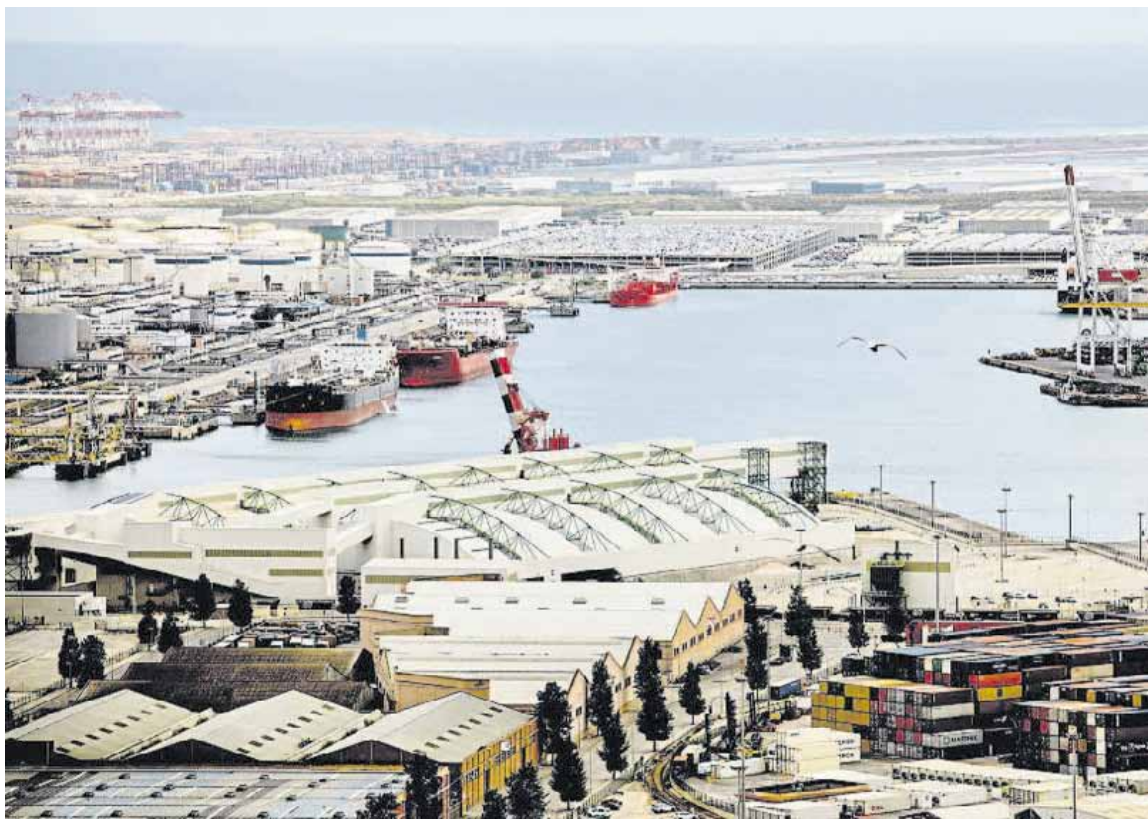
Imagen del Moll de l'Energia en el Port de Barcelona, donde se ubicará la desalinizadora flotante
