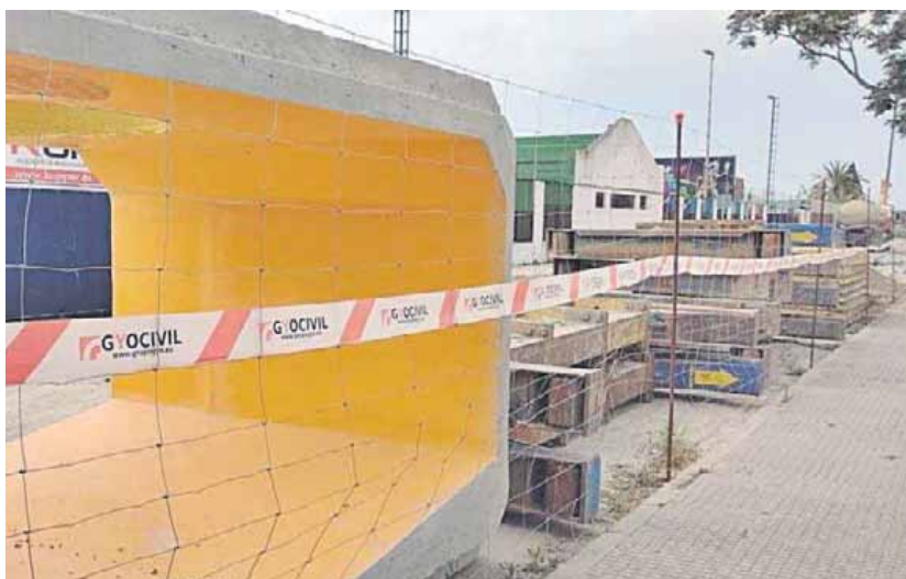
Uno de los grandes marcos de hormigón que se están instalando en la avenida de la Bajamar.
