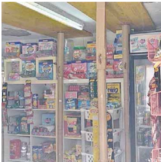
Puntales instalados en el quiosco ubicado frente al Club Náutico.
