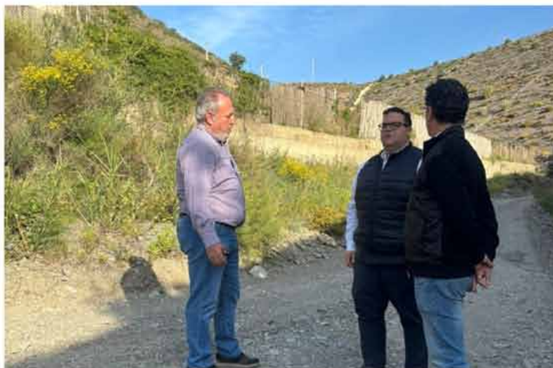
Visita a la zona de las obras en La Mamola | Foto: Gabinete
