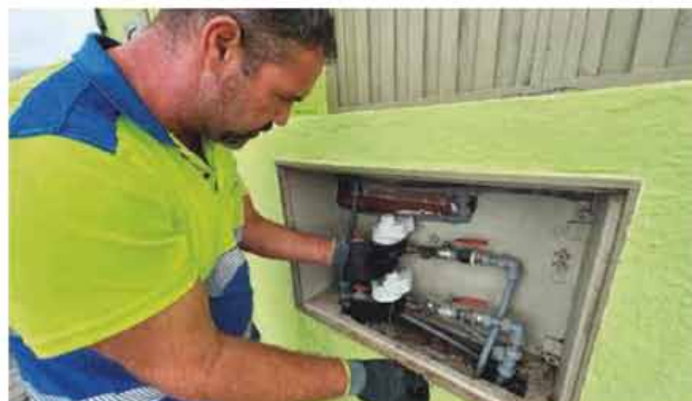
Instalación de un contador inteligente en Güimar, Tenerife. LP/DLP
